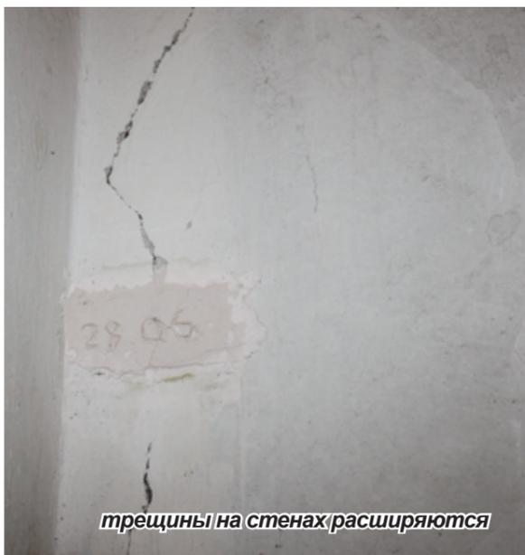
трещины на стенах расширяются
